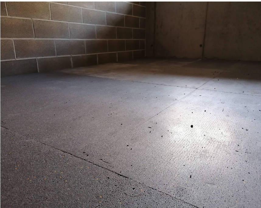
Greydur Top B RE Vicenza (VI) - Isolamento di un solaio
