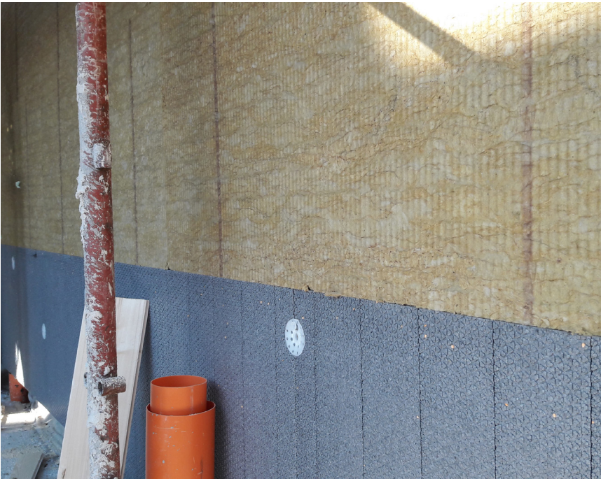
Greydur Smart RE Parma (PR) - Zoccolatura di una villa bifamiliare
