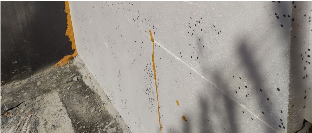
Nixdur Smart RE Macerata (MC) - Controterra di villetta unifamiliare
