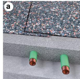
Se si utilizzano tappeti **Pavigran** da 3 fino a un massimo di 5 mm, è sufficiente posare i tappeti avendo cura di sovrapporli di almeno 10 cm.
