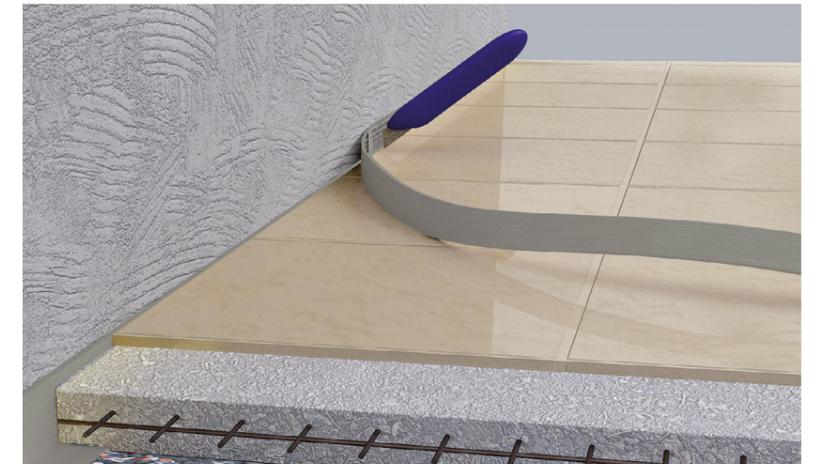
Solo dopo la posa della pavimentazione e facendo attenzione che il pavimento batta sulle strisce perimetrali e non contro la parete, rifilare il materiale in eccesso delle strisce per tutto il perimetro della stanza.
