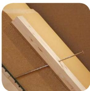
*Sul tavolato a vista viene collocata un telo freno al vapore. Sopra si posiziona uno strato di GUTEX Thermosafe-homogen®. Con GUTEX Multiplex-top® si crea una sottocopertura resistente alla pioggia.*
